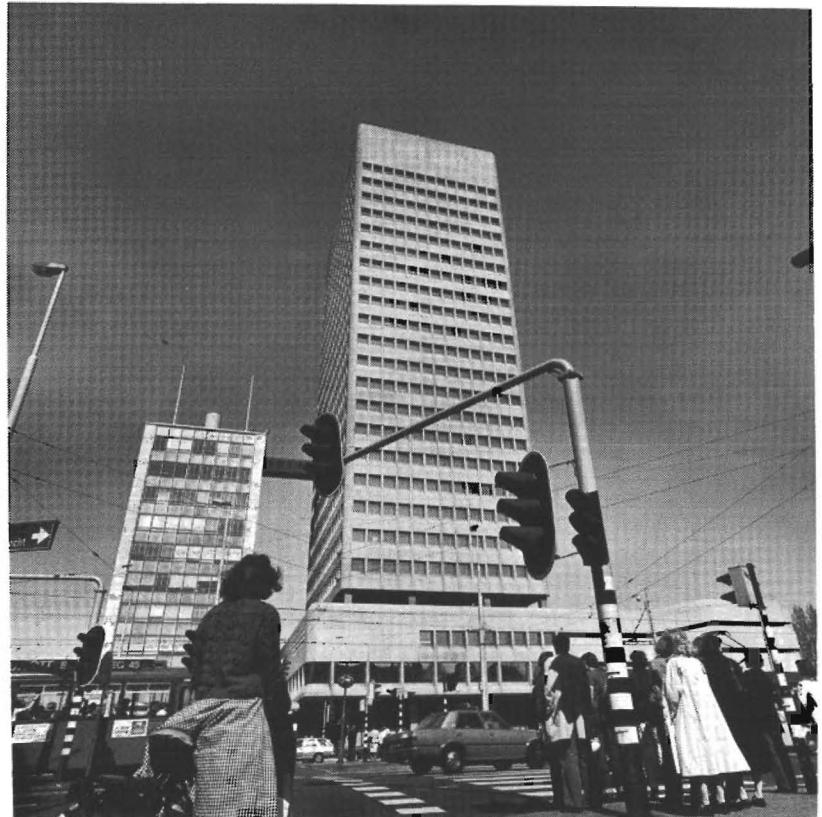
Hoofdgebouw Shell te Rotterdam
