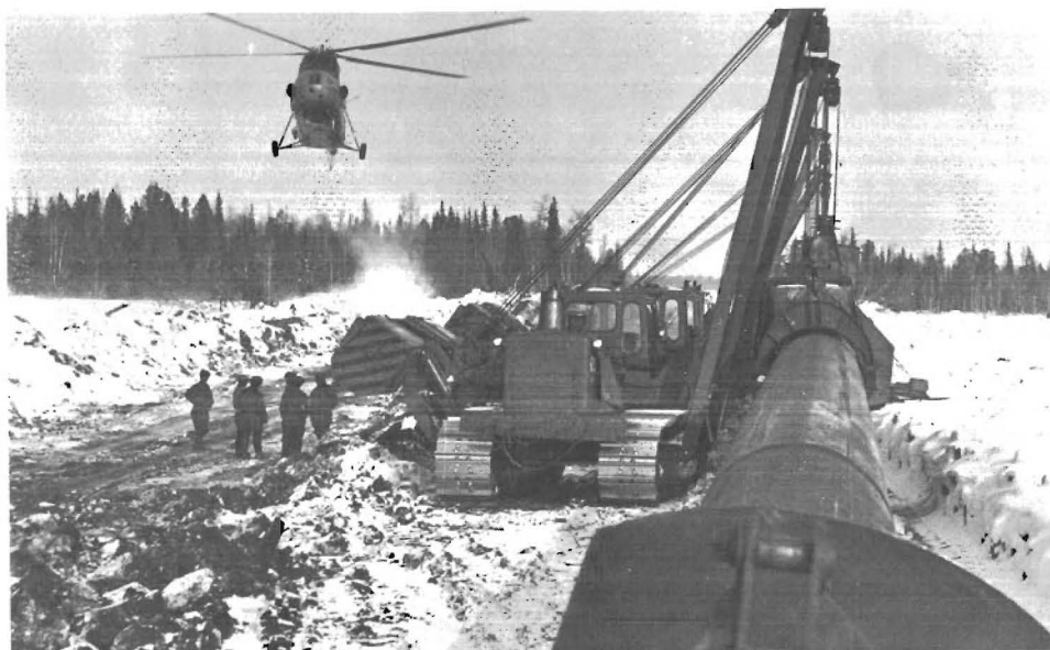
Aanleg van de pijpleidingen van West-Siberië naar Almetjevsk (aan de Wolga), 1973
